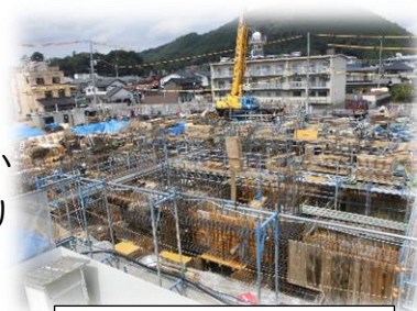
基礎工事が進んできました。
