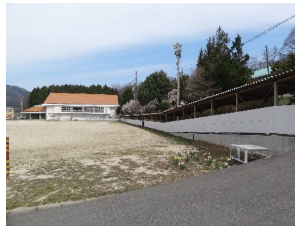
体育館連絡通路
