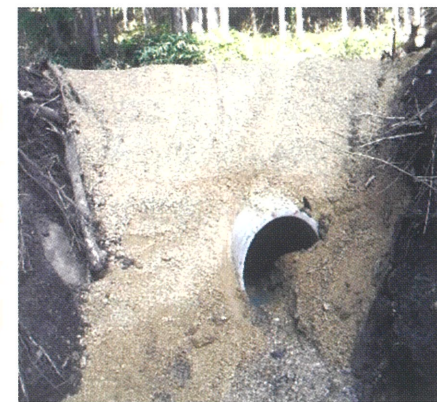
路面水を処理するためのヒューム管の埋設
