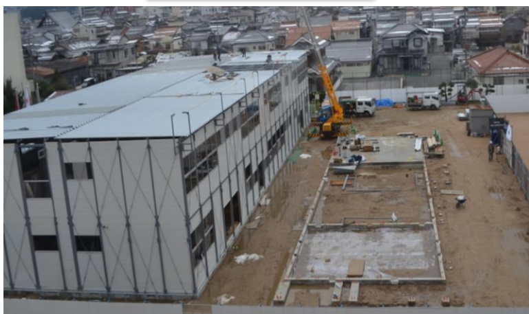
建設中の仮設校舎の様子
